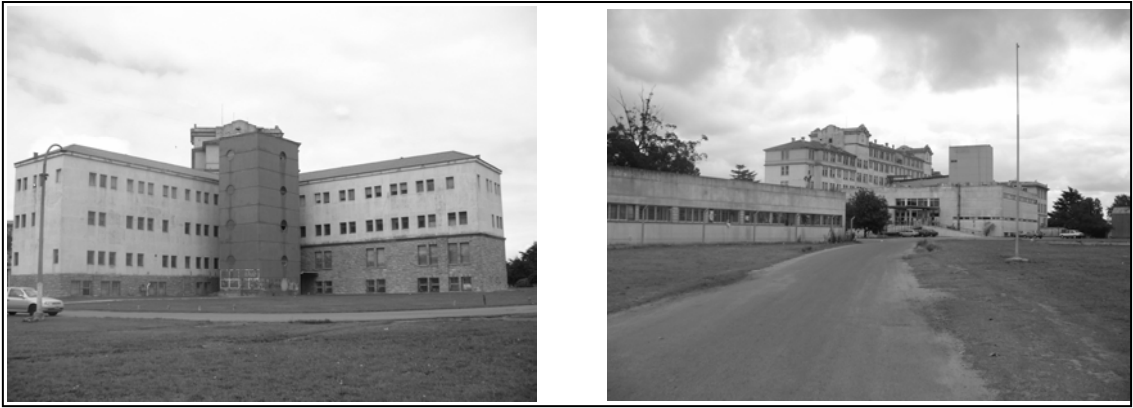
Imágenes del bloque de hormigón, de circulación vertical insertado en el encuentro de los pabellones en ángulo del extremo izquierdo y del encuentro entre el cuerpo central original y las nuevas construcciones para emergencias.
